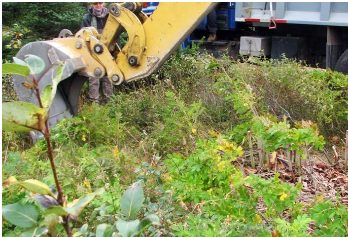
Figure 2 Technique d'excavation utilisée afin d'éradiquer la Renouée du Japon
