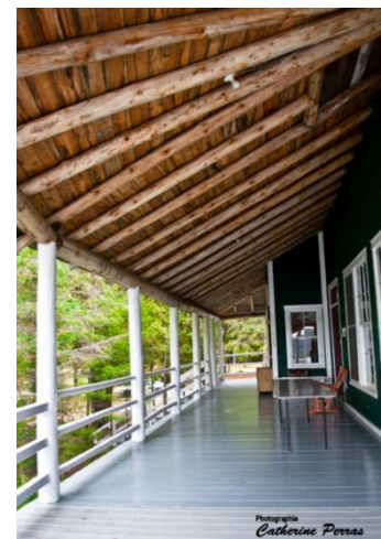
Figures 5 et 6: Galerie et balustrade du bâtiment faisant un joli clin d'œil au pont des bateaux
